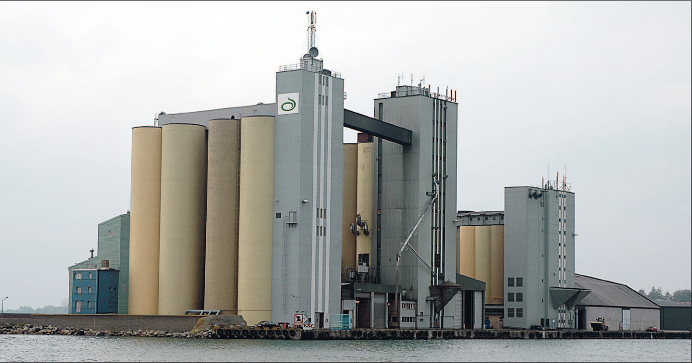
Hamninloppet domineras av dessa spannmålsilos.
